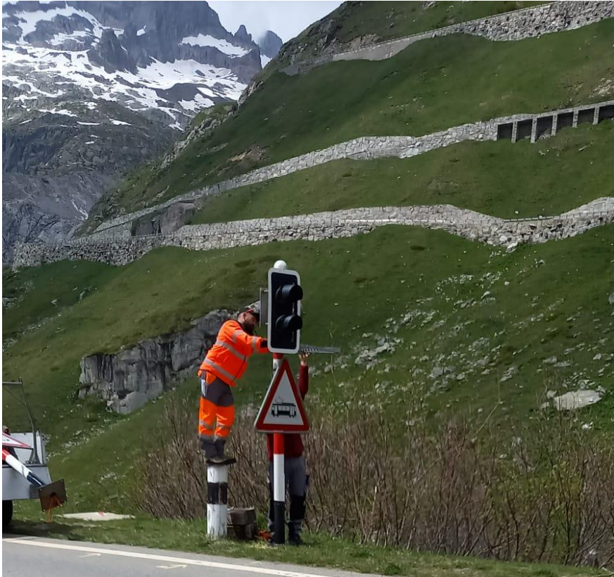
Martin Wieland richtet das Blinksignal des Bahnübergangs Furkastrasse. Foto: Toni Meier.
