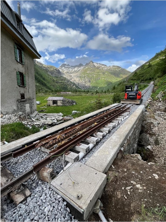
Die Zahnstangeneinfahrt auf dem Viadukt Wyssgand. Foto: Patrick Smit.
