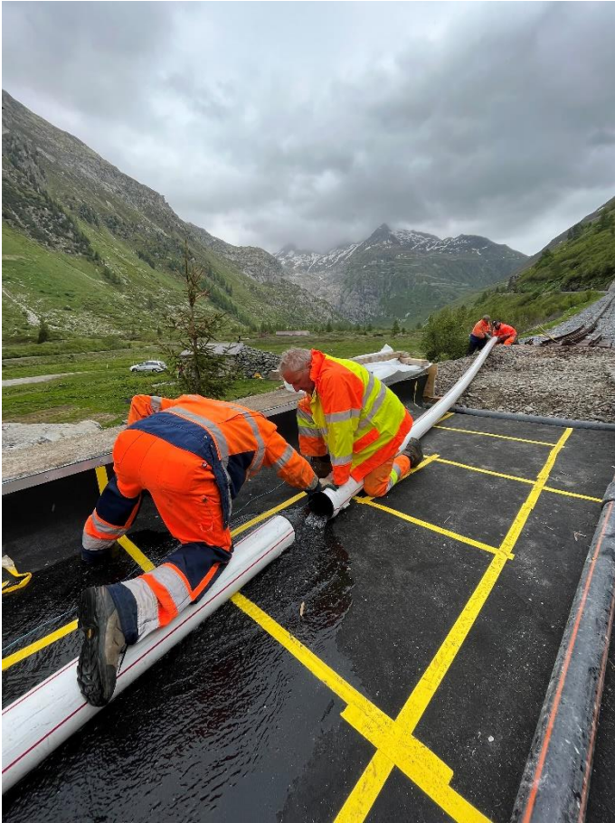
Montage des Drainagerohrs auf dem Viadukt Wyssgand beim Blauhaus in Gletsch. Foto: Patrick Smit.
