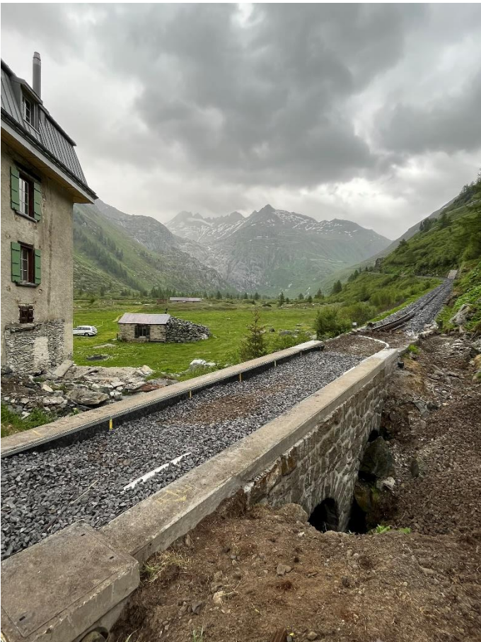
Der Schotter auf dem Viadukt Wyssgand ist eingebracht. Foto: Patrick Smit.
