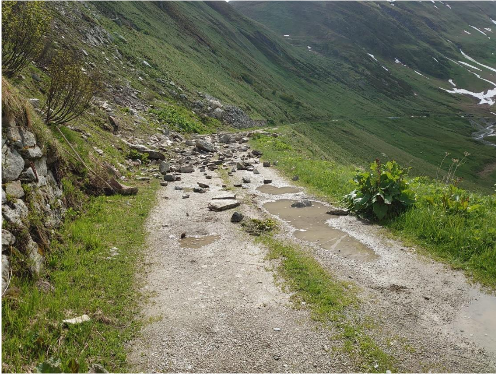
Felsräumungen oberhalb des Zufahrtsweges zur Station Muttbach-Belvédère. Foto: Ruedi Schwarz.
