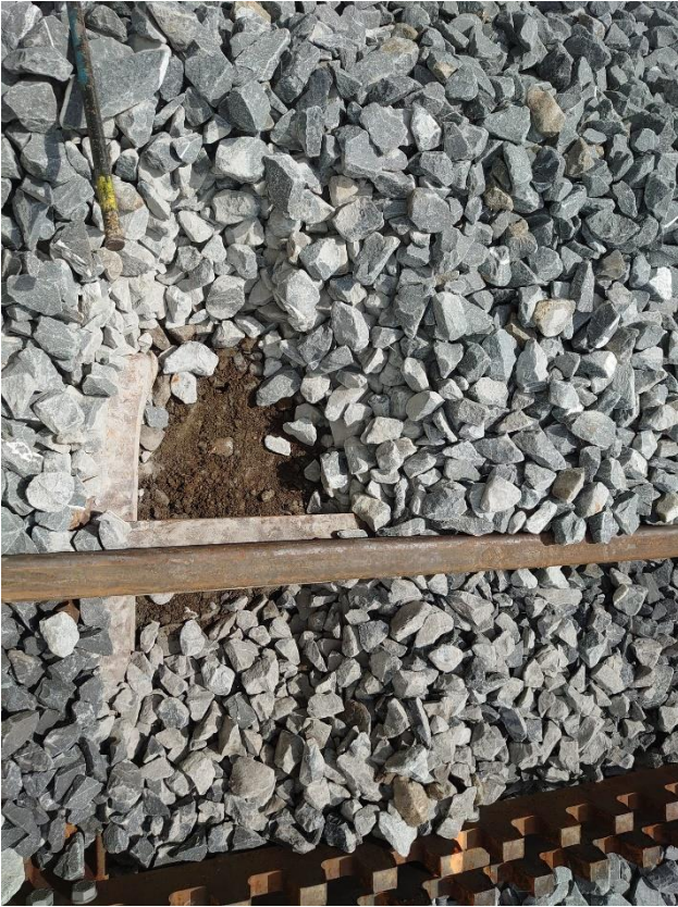
Ein Windenloch im Bereich des Totalumbaus vom Oktober 2021. Nach Pfingsten wird der Streckenabschnitt gestopft. Foto: Ruedi Schwarz.
