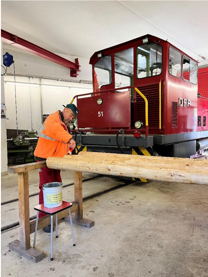
Im Stützpunkt Realp grundiert Anton Meier die Drehscheibenhebel, die Daniel Feyer in der Vorwoche für die Drehscheibe der Station Furka angefertigt hat.
