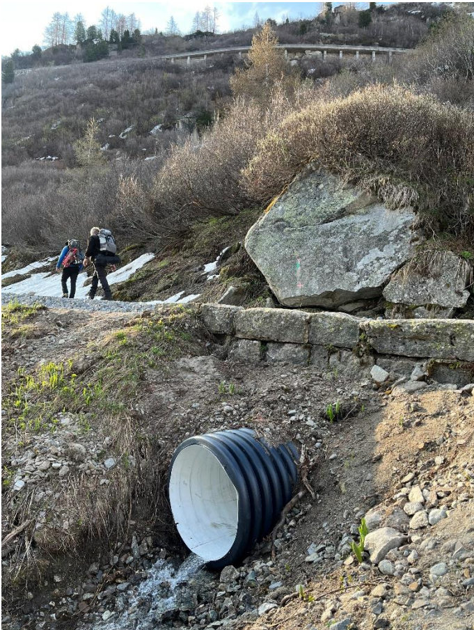
Die während des Totalumbaus vom Oktober 2021 sanierten Durchlässe führen das Schmelzwasser tadellos ab. Foto: Patrick Smit.
