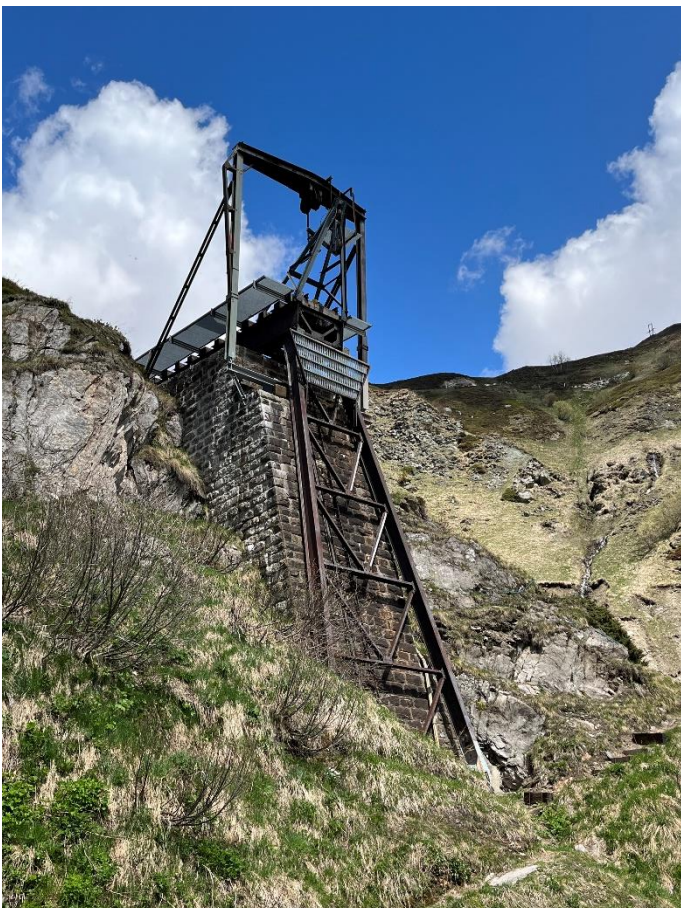
Das bergseitige Element der Steffenbachbrücke in Winterstellung.
