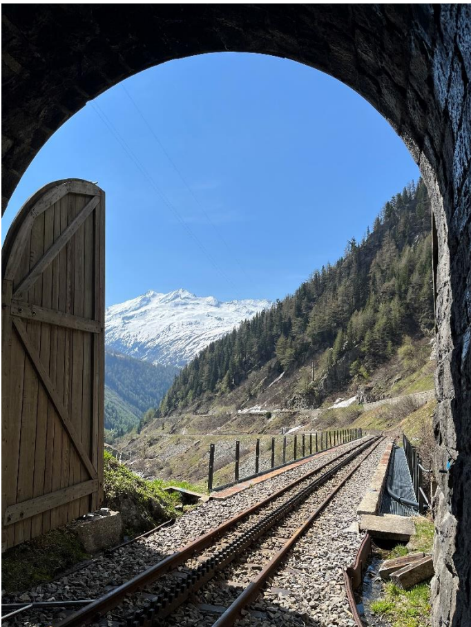
Blick aus dem talseitigen Tunnelportal des Kehrtunnels in die Rottenschlucht. Foto: Patrick Smit.
