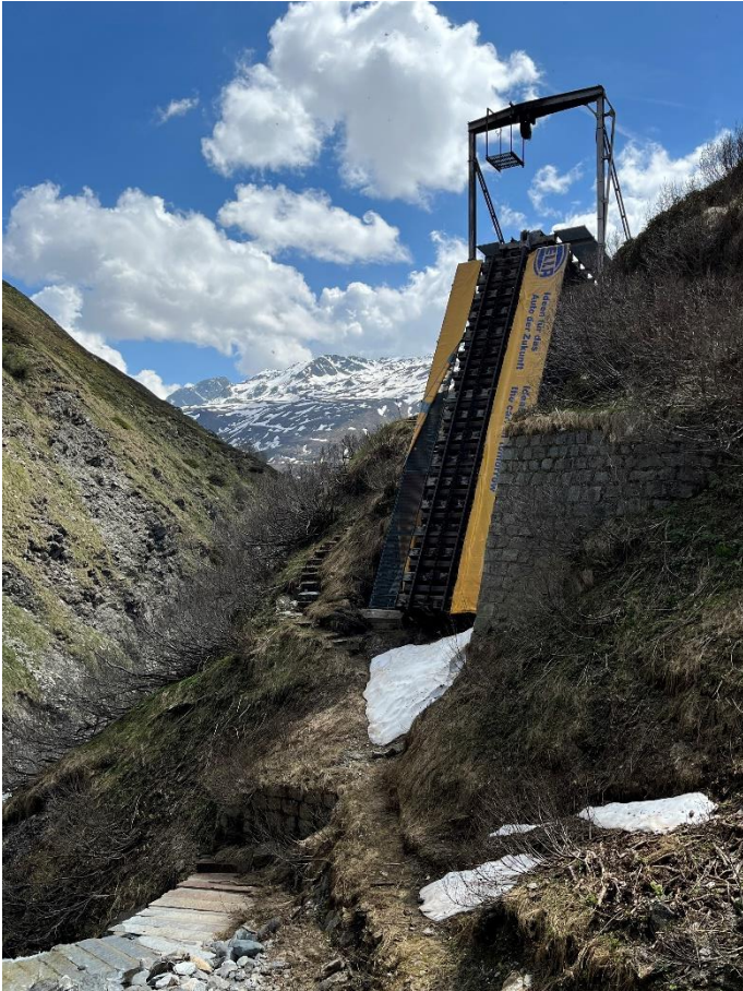
Das talseitige und mittlere Element der Steffenbachbrücke in Winterstellung.
