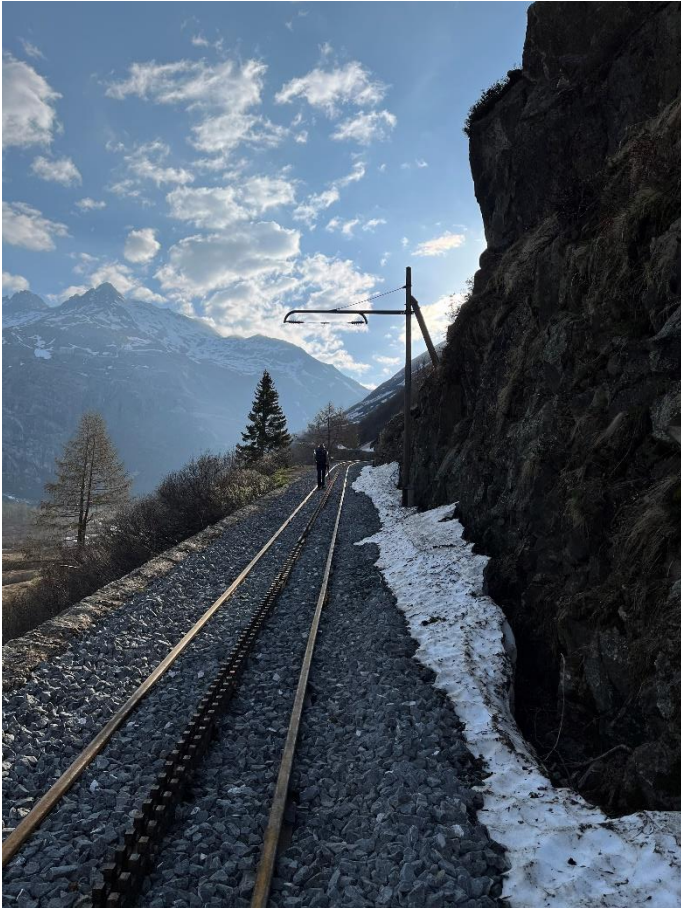
Wunderbare Morgenstimmung beim Fahrleitungsmast oberhalb des Bahnhofs Gletsch. Foto: Patrick Smit.
