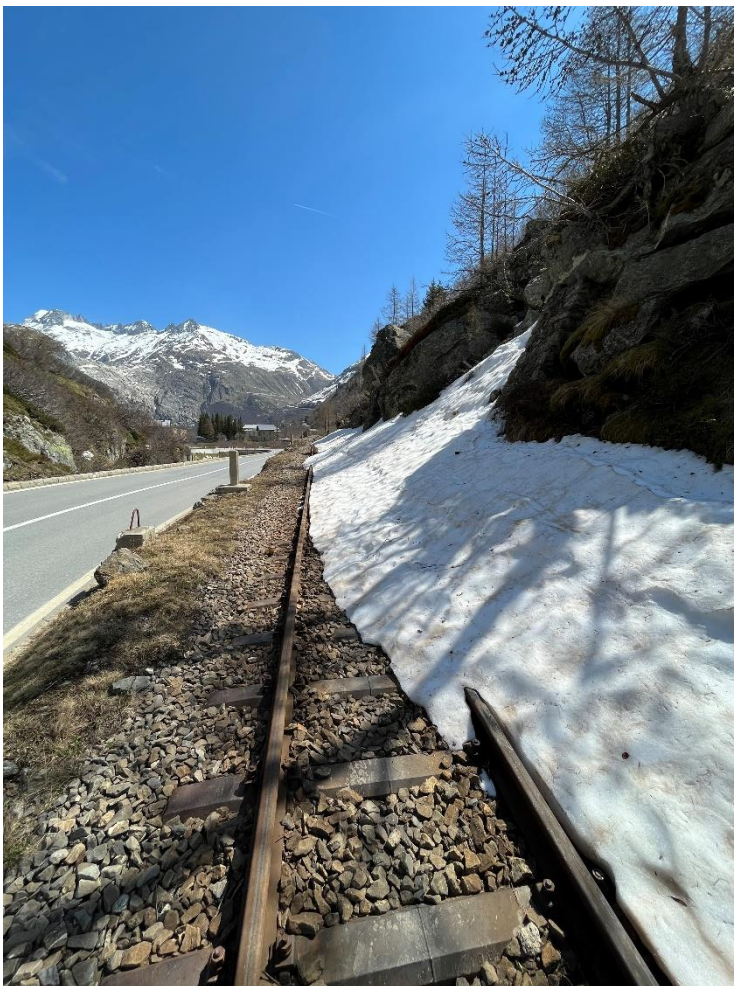
Dieser Schneewall auf dem Oberbau zwischen Bahnübergang Rotten und Remise Gletsch wird in den nächsten zwei Wochen weiter wegschmelzen, so dass der Restschnee von Hand oder mit der Anbaufräse der HGm 51 geräumt werden kann. Foto: Patrick Smit.
