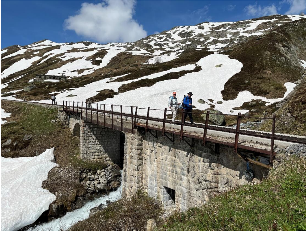
Die Sidelenbrücke zwischen Furka und Tiefenbach. Foto: Patrick Smit.
