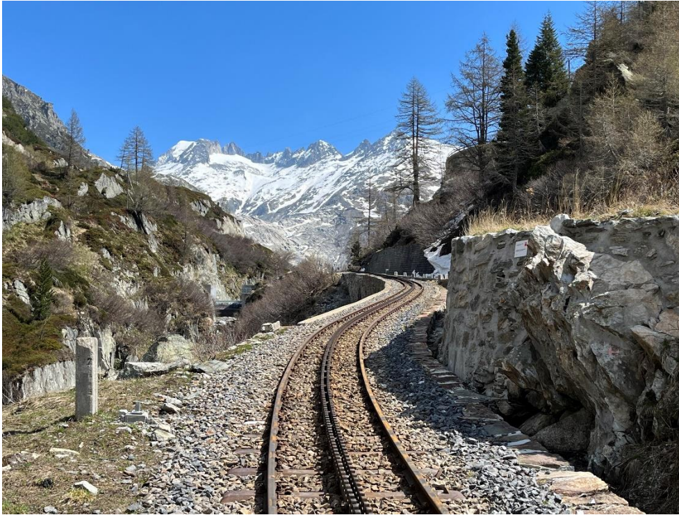
Blick vom Lehnenviadukt Biel Richtung Gletsch. Im Hintergrund sind die Furkahörner und der Galenstock sichtbar. Foto: Patrick Smit.
