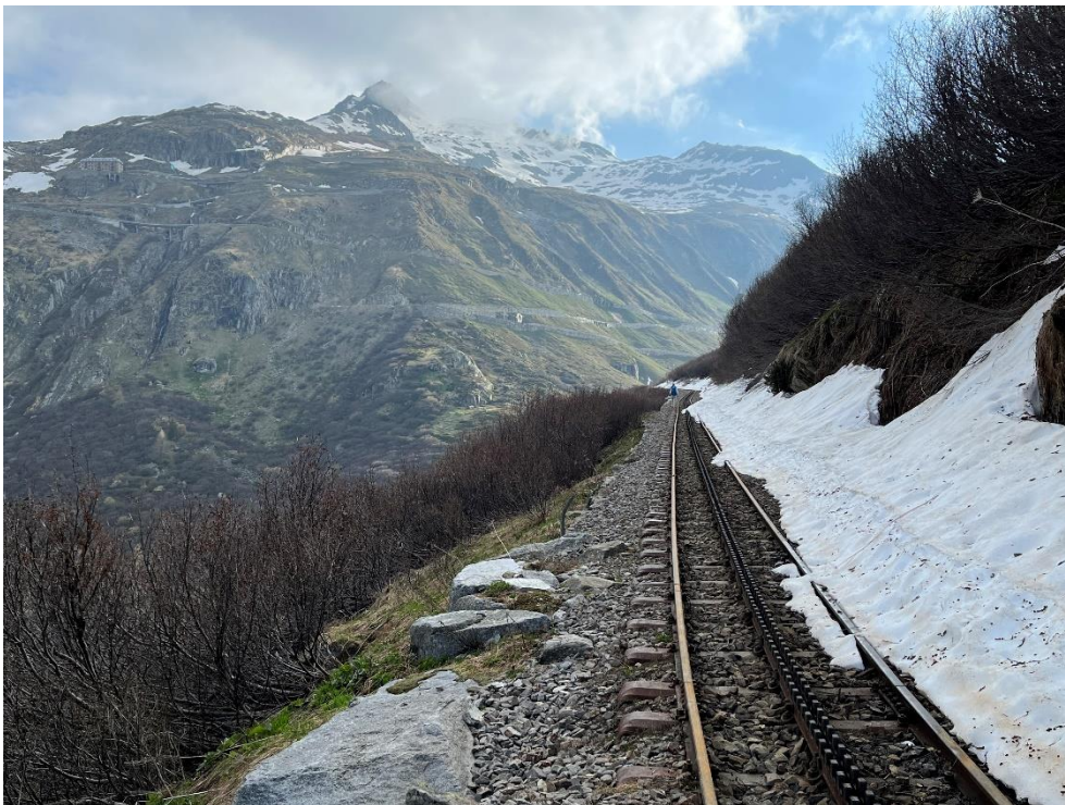
Blick von der Hilfsbrücke bei Km 47.8 bergwärts. Foto: Patrick Smit.
