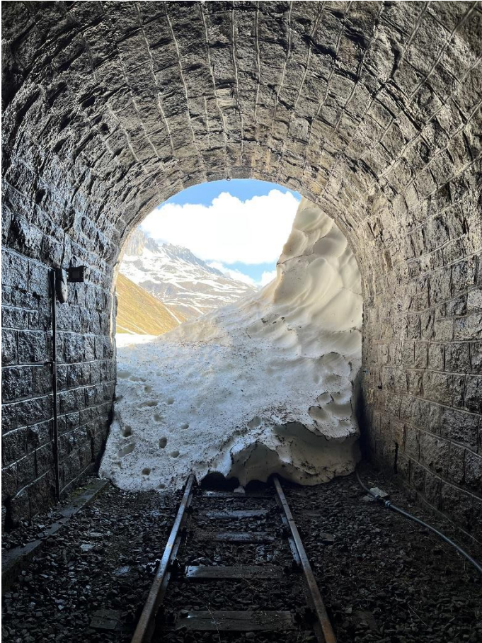
Blick vom östlichen Portalbereich des Scheiteltunnels Richtung Station Furka. Foto: Patrick Smit.
