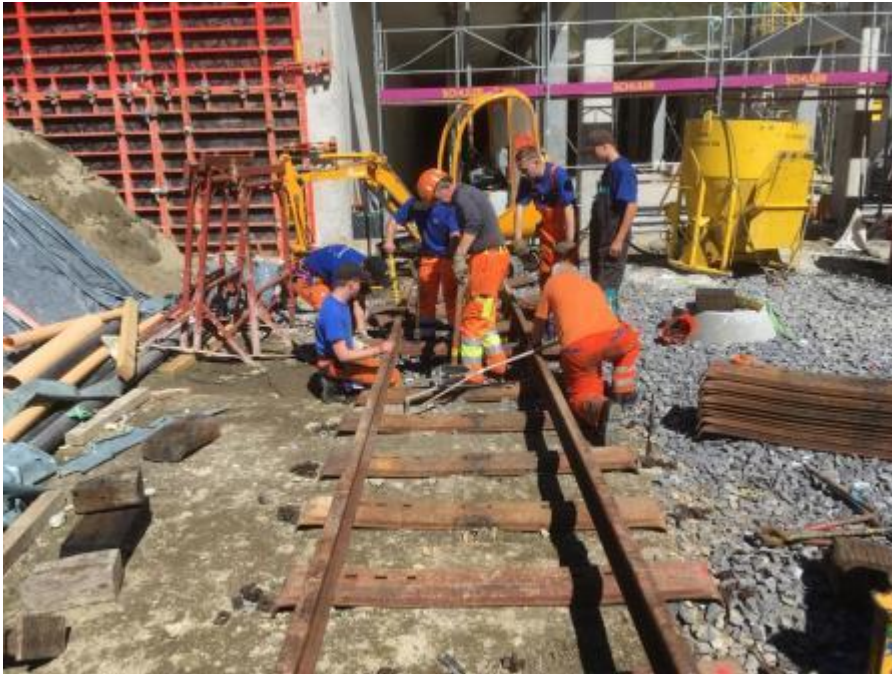
Realp Gleisfeld Wagenremise: Beihilfe Schienenschweissungen
