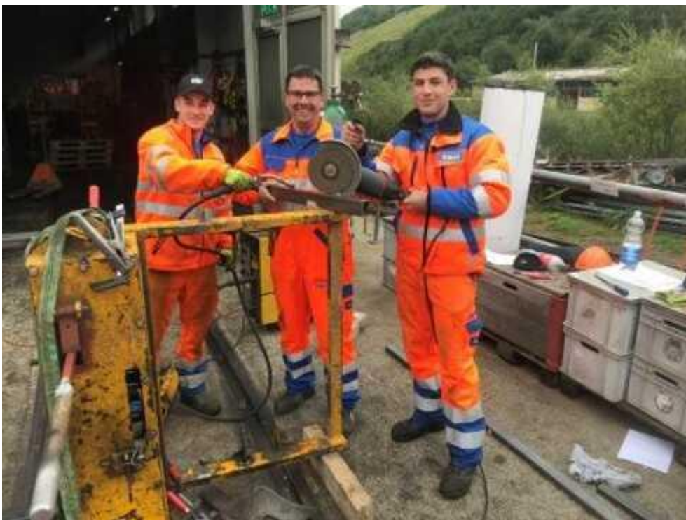
Realp Wagenremise: Beischienen vorbeugen und montieren
