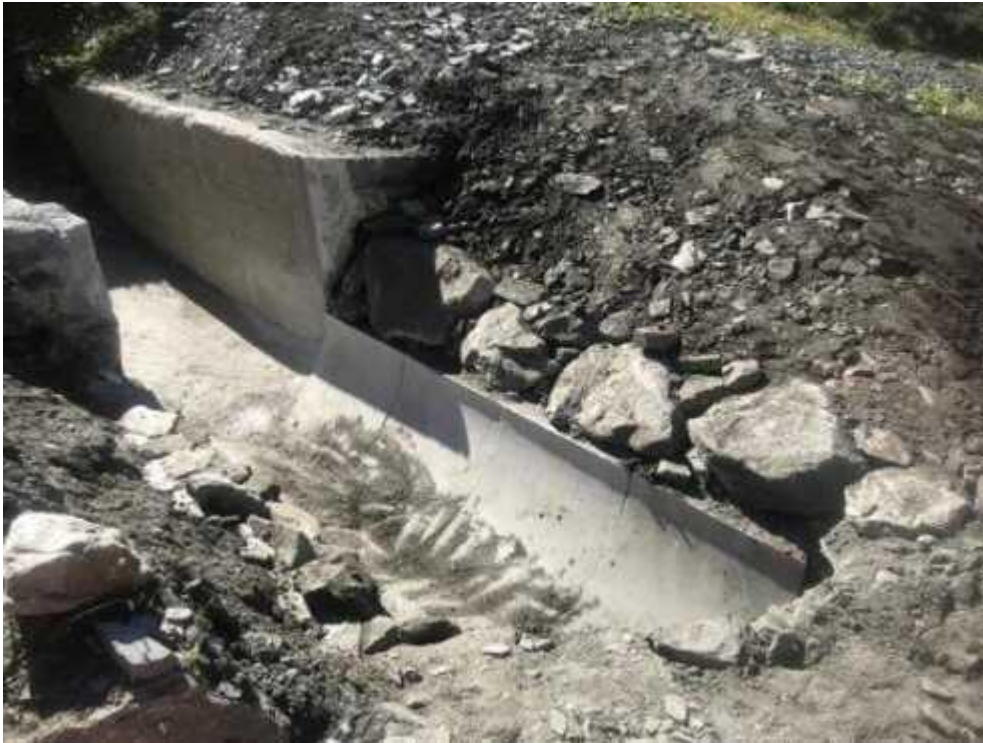
Tiefenbach - Realp km 57.071: Bankettsicherung mit Steinkörben erstellen
