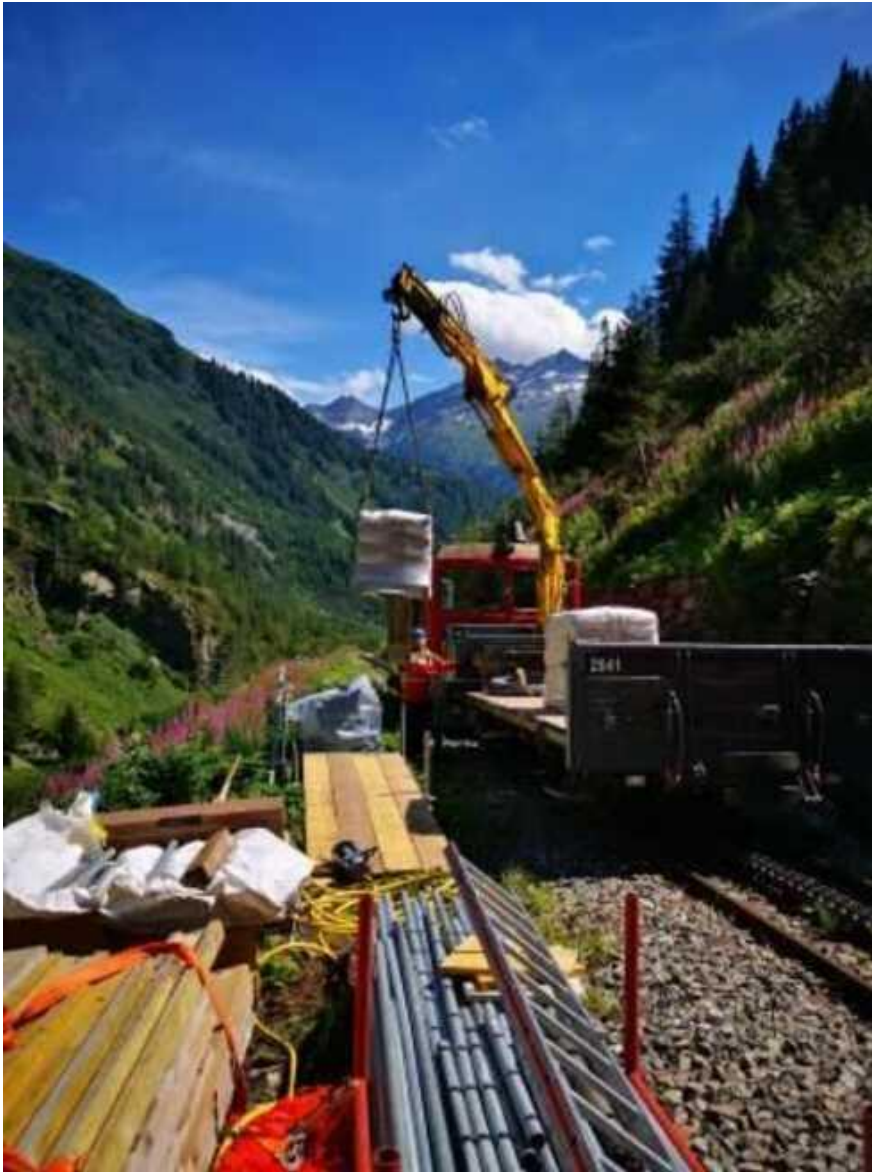
Aufführen von Baumaterial für den zu sanierenden Lehnenviadukt „Mässweid“ bei km 44.450
