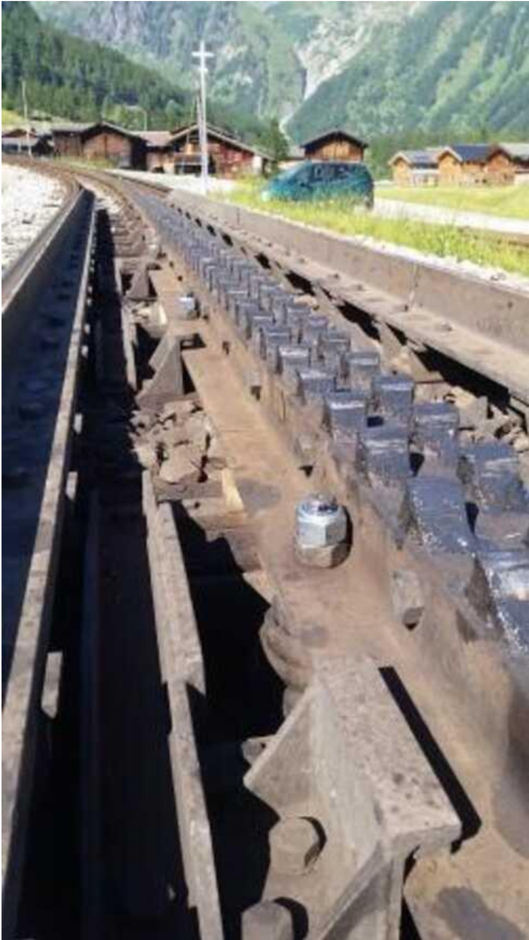
Die Federbolzen der Zahnstangeneinfahrten werden mit Stoppmuttern gesichert
